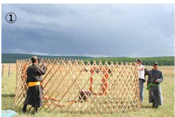
①ゲルの壁「ハナ」の骨組みを立てる
