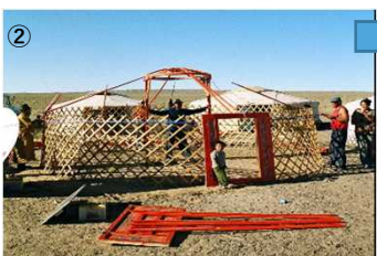
①ゲルの壁「ハナ」の骨組みを立てる
