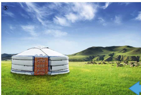
⑤革製3つのひも「ブスルール」でしっかりと締めて完成
