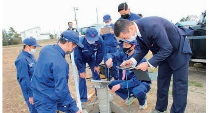
▲滝川市スマート水田実証プロジェクト 北海道滝川工業高等学校と連携した自動給水栓防護施設開発
